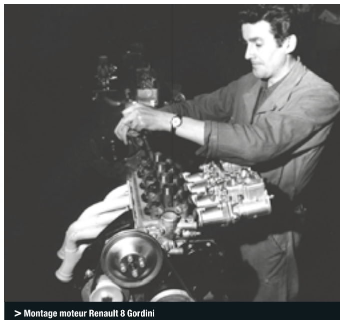
> Montage moteur Renault 8 Gordini
